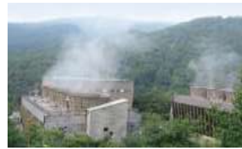
【地熱発電設備】
